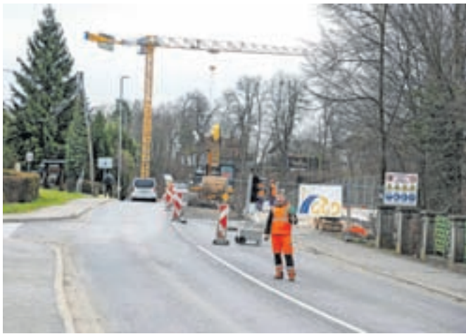
Na Betinovem klanecu bo po novem polovična zapora vzpostavljena le v marcu, saj bodo gradbena dela v obeh fazah zaključena že do 24. marca. / Foto: Tina Dokl
