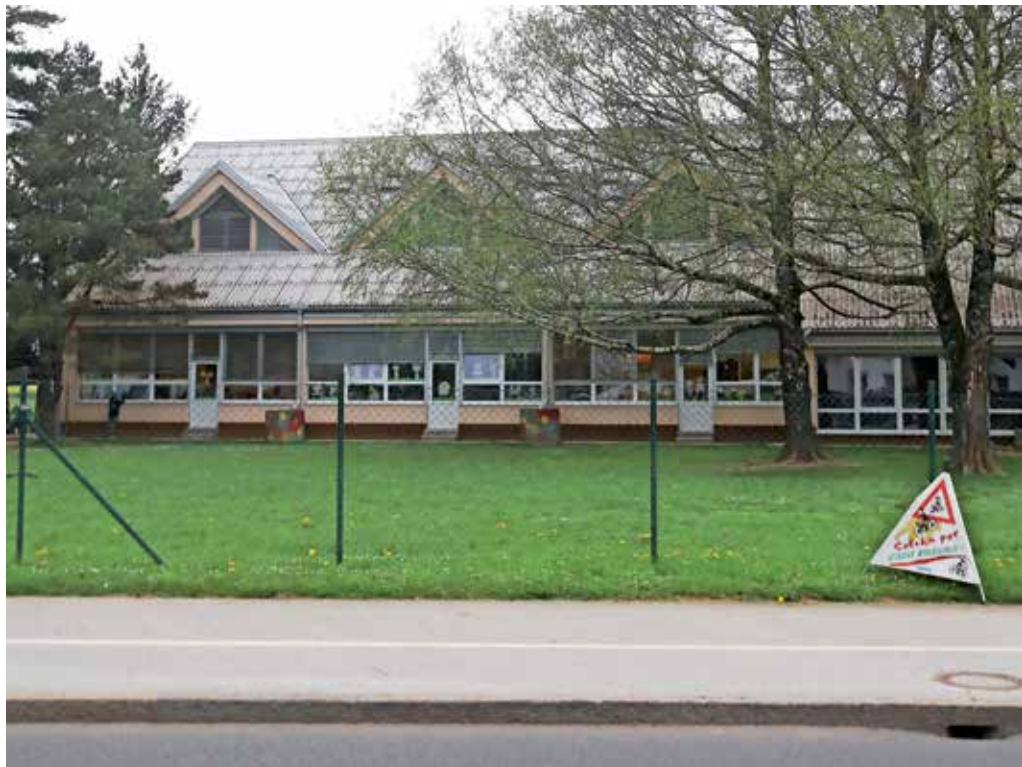
Mestna občina Kranj bo septembra začela prvo fazo obnovitvenih del na Podružnični šoli Kokrica – OŠ Franceta Prešerna in Vrtcu Kokrica. / Foto: Gorazd Kavčič
