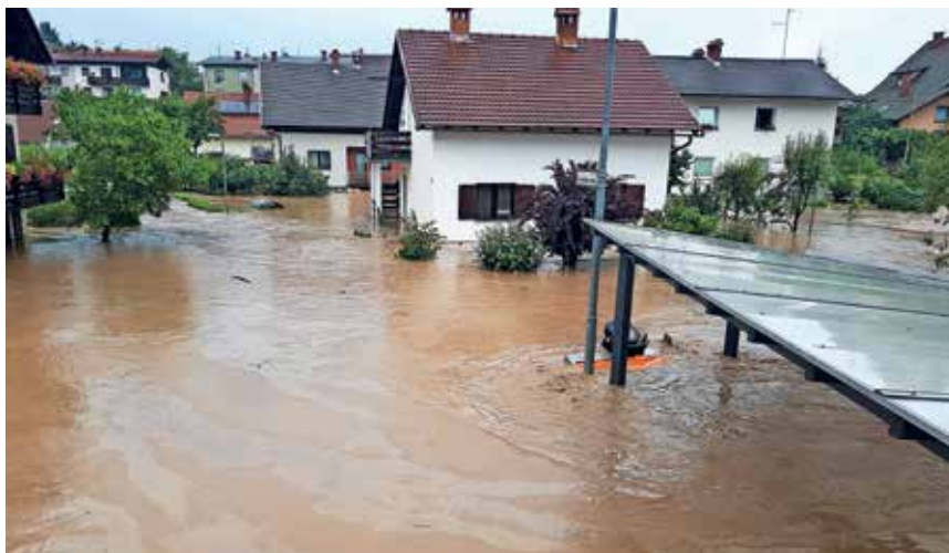
Poplavljen križišče Sorške in Demšarjeve ceste / Foto: arhiv krajanov
