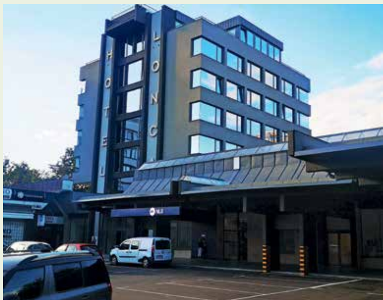
Na veselje Ločanov in obiskovalcev je prenovljena stavba hotela znova zasijala. / Foto: Vilma Stanovnik
