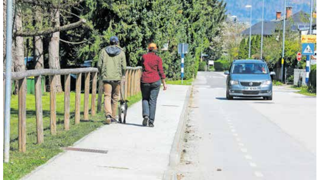
Pločnik na Jelenčevi ulici v Kranju zagotavlja večjo varnost pešcev v prometu, žal pa v deževnem vremenu na vozišču nastajajo luže. / Foto: Tina Dokl
