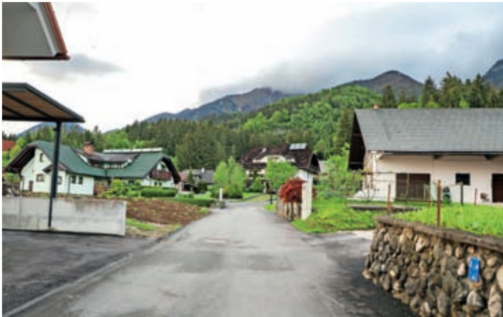
V Mačah se zdaj izvajajo priklopi na kanalizacijsko omrežje. / Foto: Tina Dokl
