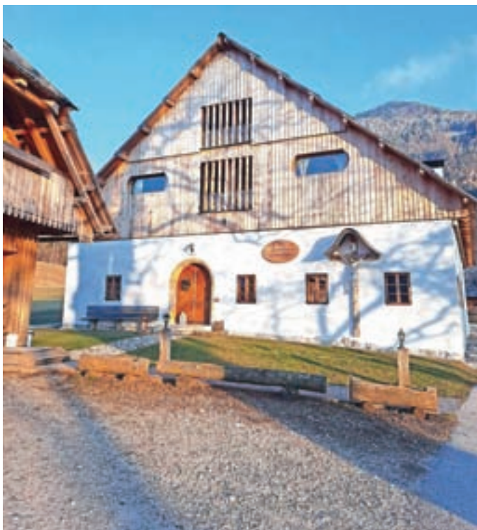
Stanje danes, ko je obnova končana
