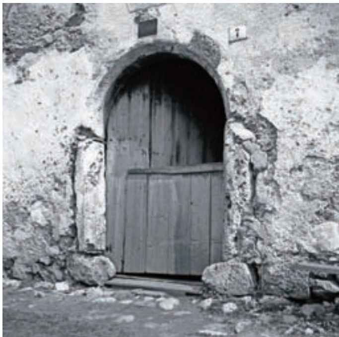
Vhod Šenkove hiše (ok. leta 1950) kaže na zelo slabo stanje stavbe, v katero sta se po vojni vselila babica Mimi in ata Ludvik Virnik.
