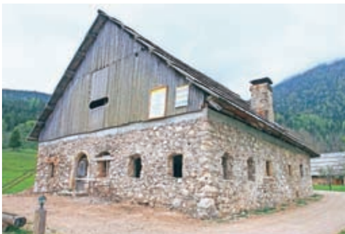
Odstranjen omet med zadnjo obnovo hiše razkriva doslej zakrite spremembe, ki so se zgodile na hiši v njeni petstoletni zgodovini in so pomembna osnova za zgodovinske analize.
