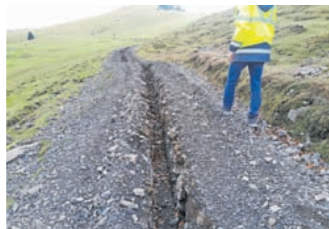
Gradnja kablovoda na Veliki planini / FOTO: ELEKTRO LJUBLJANA
