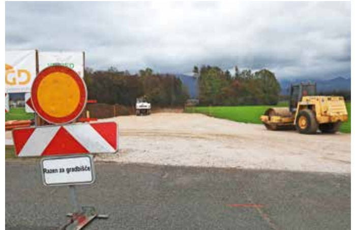
Odsek Britof–Hotemaže bo v glavlini potekal skozi šenčursko občino. / Foto: Gorazd Kavčič
