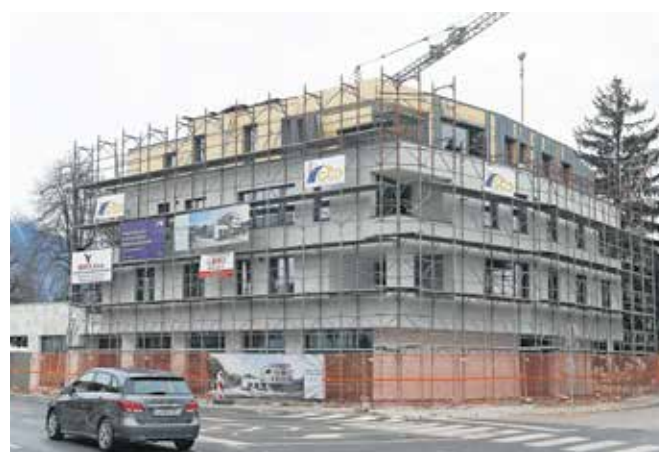
Gradnja novih stanovanj v nekdanjem TVD Partizan Radovljica / FOTO: GORAZD KAVČIČ
