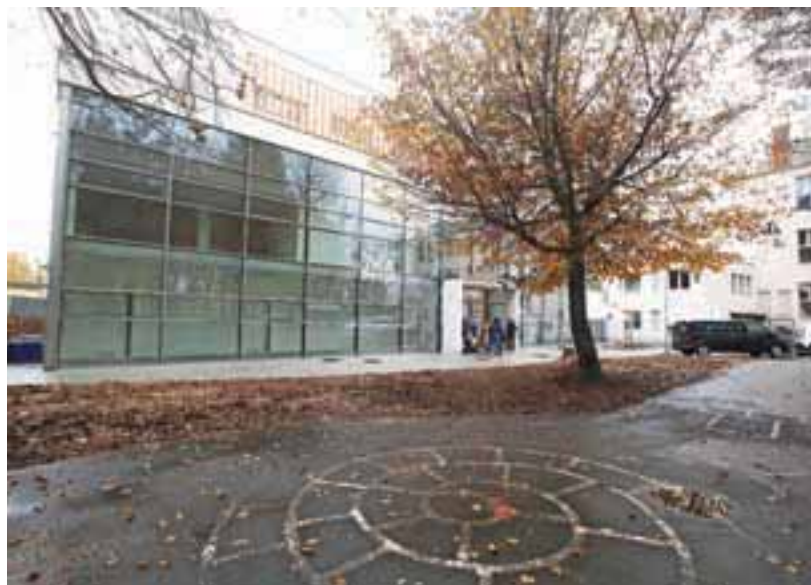
Upajo, da bodo nove prostore lahko začeli uporabljati v začetku leta 2023, ko naj bi bilo uporabno dovoljenje naposled le izdano. / Foto: Gorazd Kavčič
