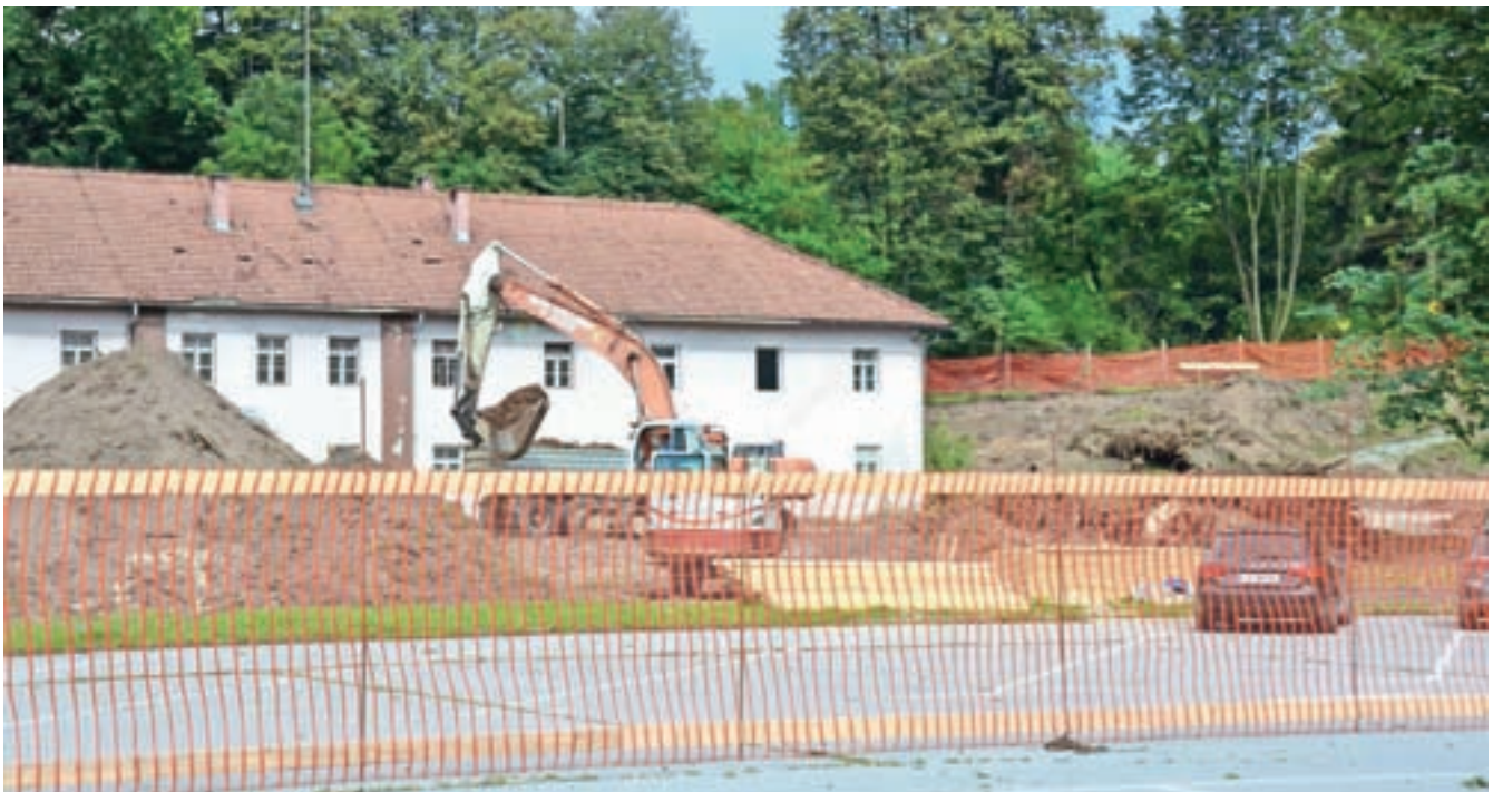
V začetku septembra so se začela rušitvena dela znotraj gradbiščne ograje vrtca.
