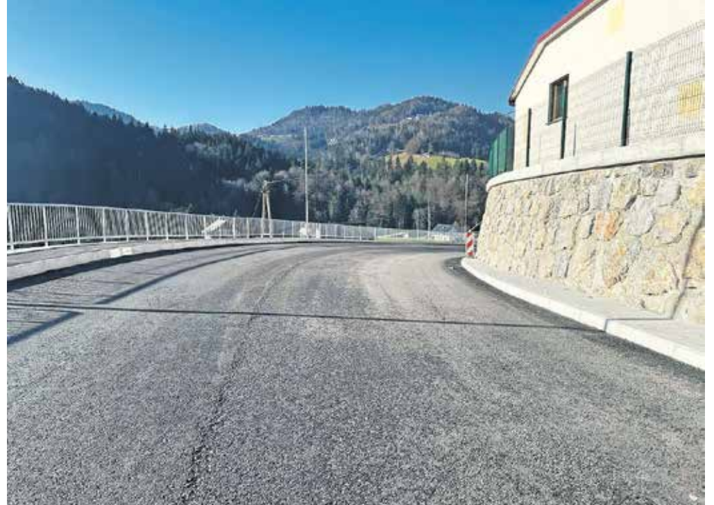
Na Selu so že skoraj zaključili obnovo ceste, manjka le še fini asfalt. / FOTO: ARHIV OBČINE
