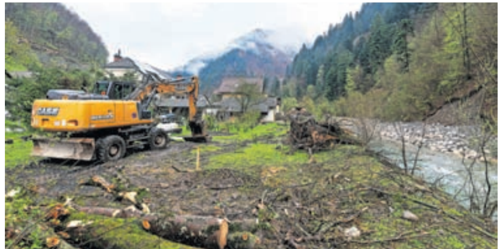
Minuli teden so se začela dela na območju obvoznice v Železnikih. / FOTO: SIMON BENEDIČIČ
