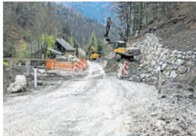
Rekonstrukcija ceste od Loga proti Rudnu / FOTO: TINA DOKL
