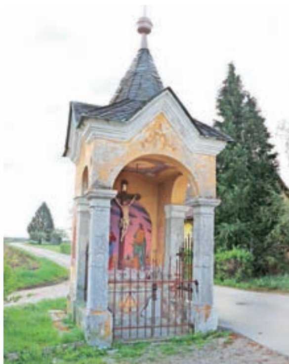
Sanacijska dela na kapelici na cestnem križišču proti Ilovki naj bi stekla maja.
