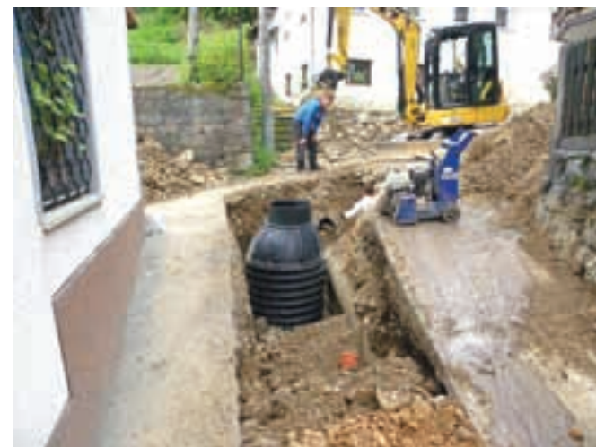
Gradnja kanalizacije v Kropi je zelo zahtevna. Krajanom se zahvaljujemo za razumevanje!
