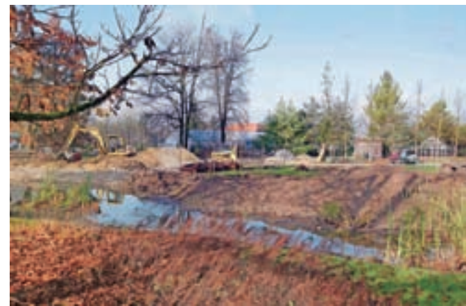
Novi vhod, ki ga že gradijo, bo umeščen med dosedanja vhod in vrtni center ter malenkost zamaknjen v sam park. / Foto: Gorazd Kavčič
