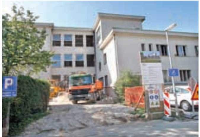
Letos poleti se je začela prenova nekdanje srednje ekonomske šole.
