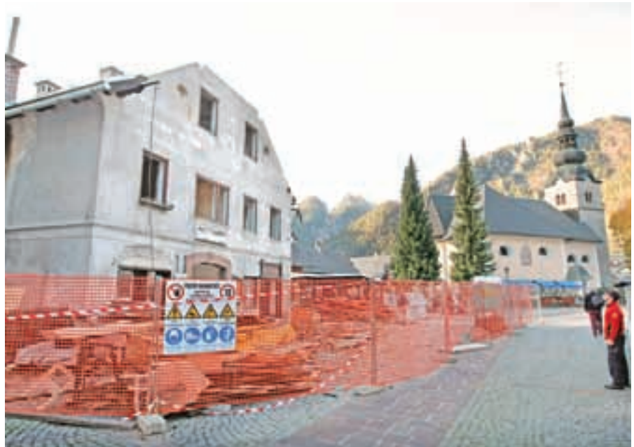
Na mestu starega Ljudskega doma bo kmalu zrasla nova stavba
