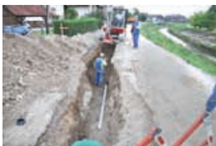
Gradnja kanalizacije na Veselovem nabrežju v Mengšu
