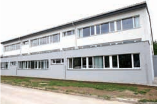
Osnovna šola Predoslje je energetska prenovljena.
