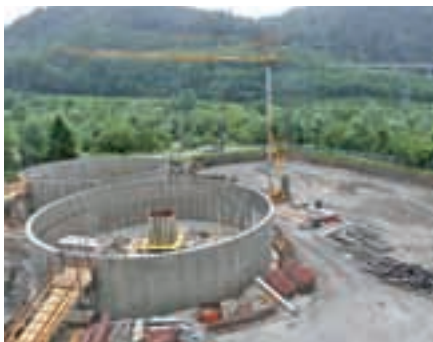
Projekt nadgradnje centralne čistilne naprave
