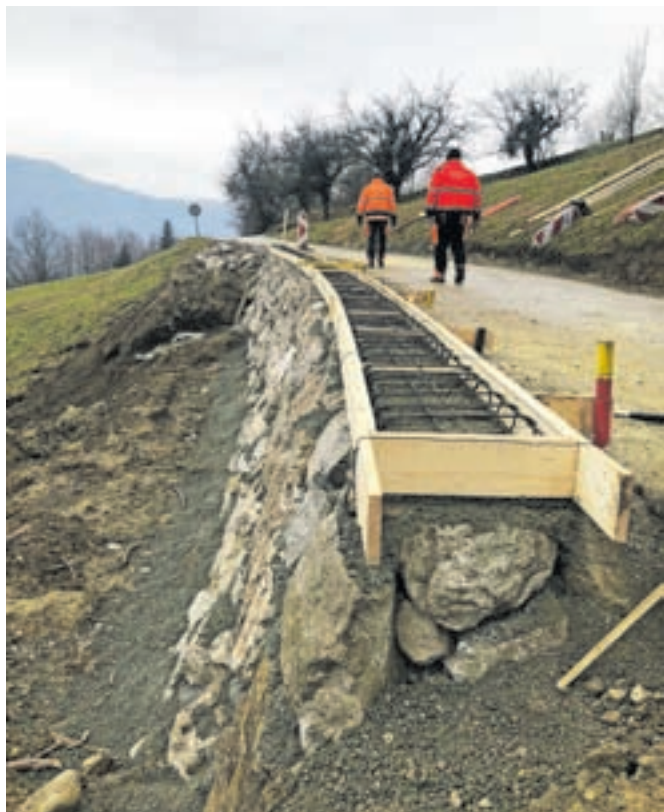
Sanacija plazov / Foto: Občina Kamnik
