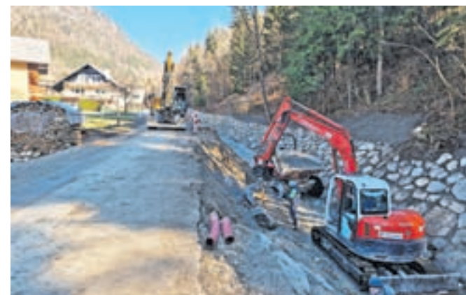
Sanacija vodotokov / Foto: Občina Kamnik
