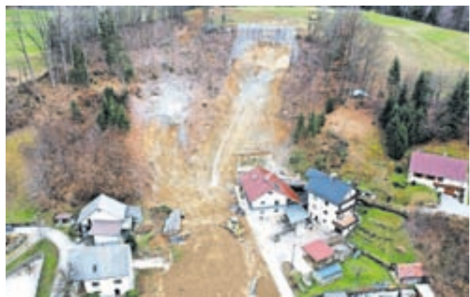
Sanacija plazov / Foto: Občina Kamnik
