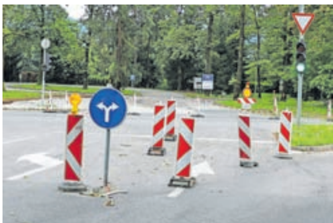
Zaradi gradnje krožišča je promet v Lipici oviran.
