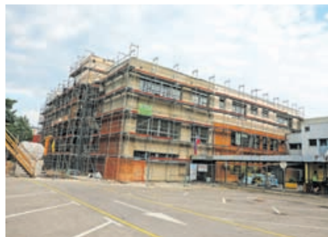
Obnova OŠ Jela Janežiča se bo malce zavlekla, gradbena dela pa naj bi bila končana do septembra. / FOTO: TINA DOKL
