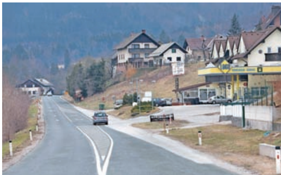
Državno cesto skozi Tupaliče naj bi začeli rekonstruirati jeseni. / Foto: Gorazd Kavčič
