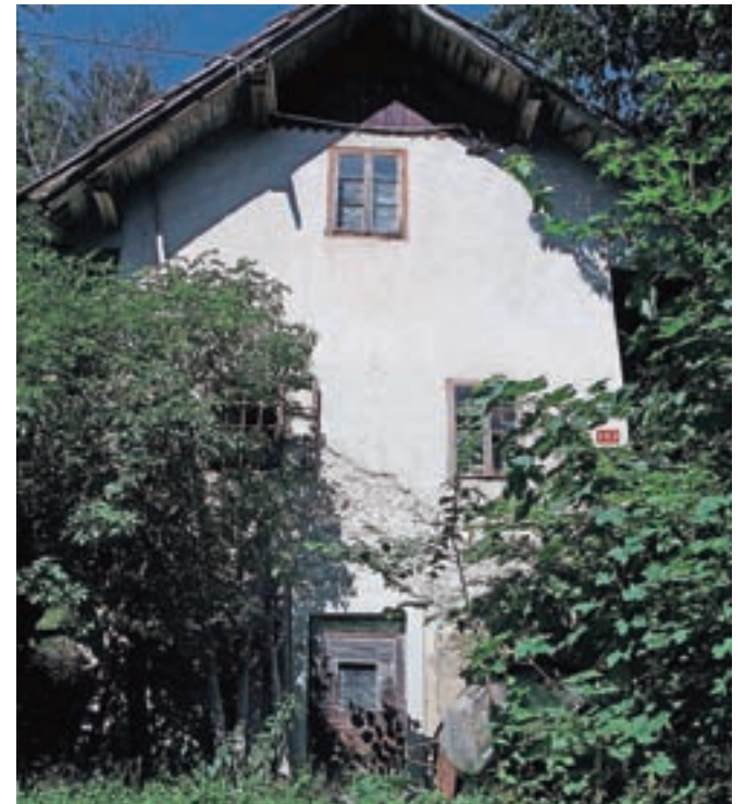
Na temeljih te hiše je stala rojstna – gozdna hiša Jakoba Knafliča v Spodnjih Gorjah 58 (danes Spodnje Gorje 162). / Foto: Franci Knaflič
