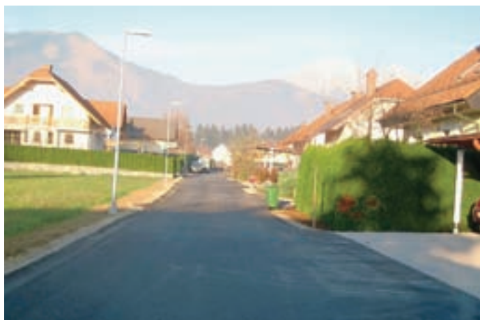
Asfaltiranje ulice na severu Britofa
