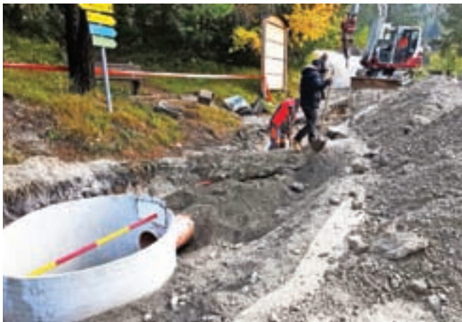
V Naselju Ivana Krivca v Jasni občina ureja meteorno kanalizacijo. / Besedilo: Suzana P. Kovačič, foto: Občina Kranjska Gora, S. K.
