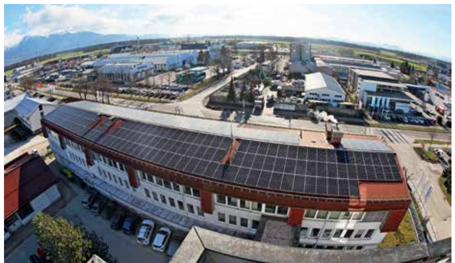
Skupina Elektro Gorenjska stoji v odlični formi ob začetku nove ere energetike, kar se odraža v kontinuiranih investicijah v infrastrukturo, izvajanju številnih investicijskih projektov in celostnem pristopu k poslovanju. / FOTO: GORAZD KAVČIČ
