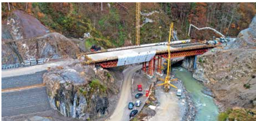
Urejanje območja zadrževalnika vode pod Sušo, kjer so sredi novembra zabetonirali nov most čez bodočo zemeljsko pregrado / FOTO: ARHIV OBČINE ŽELEZNIKI / ANDREJ TARFILA
