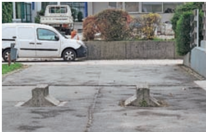
V načrtu je, da bo Komunala Kranj betonski oviri zamenjala z odsevnimi količki. / Foto: Sonja Mašič
