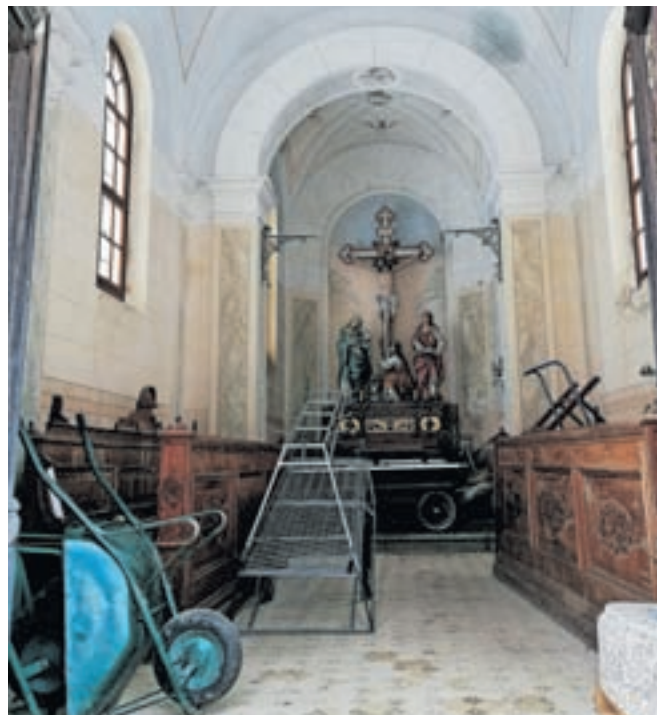
Obnova, ki jo bodo izvajali letos in prihodnje leto, zajema celostno prenovo notranjosti pokopališke kapele.
