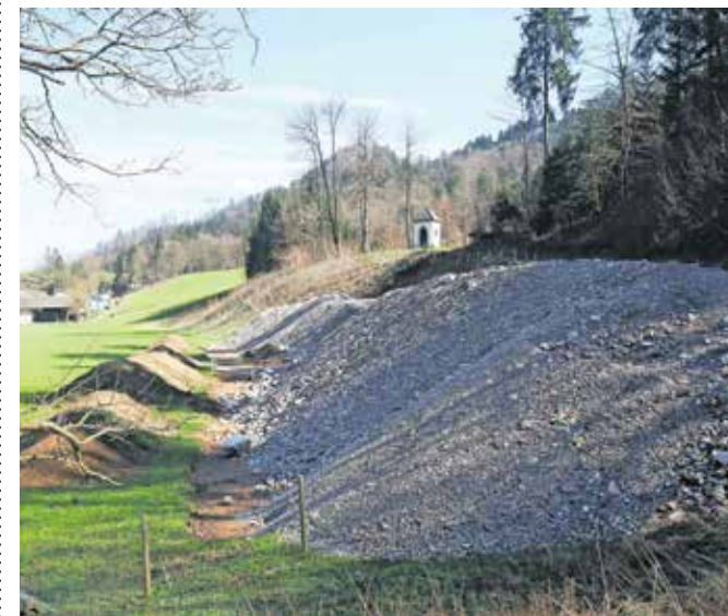
Sanacija plazu v bližini Dvorca Visoko / Foto: Gorazd Kavčič
