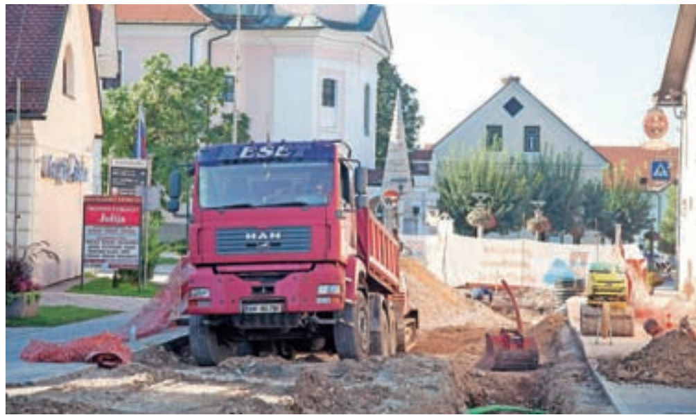
Gradnja komunalne infrastrukture v Cerkljah / FOTO: ALEŠ SENOŽETNIK
