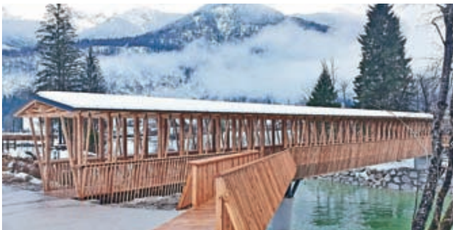
Novi most za kolesarje in pešce v Kamnjah
