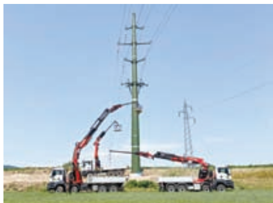
Štirje novi poligonalni stebri v Škofji Loki so tehnična inovacija zaposlenih v Elektru Gorenjska.
