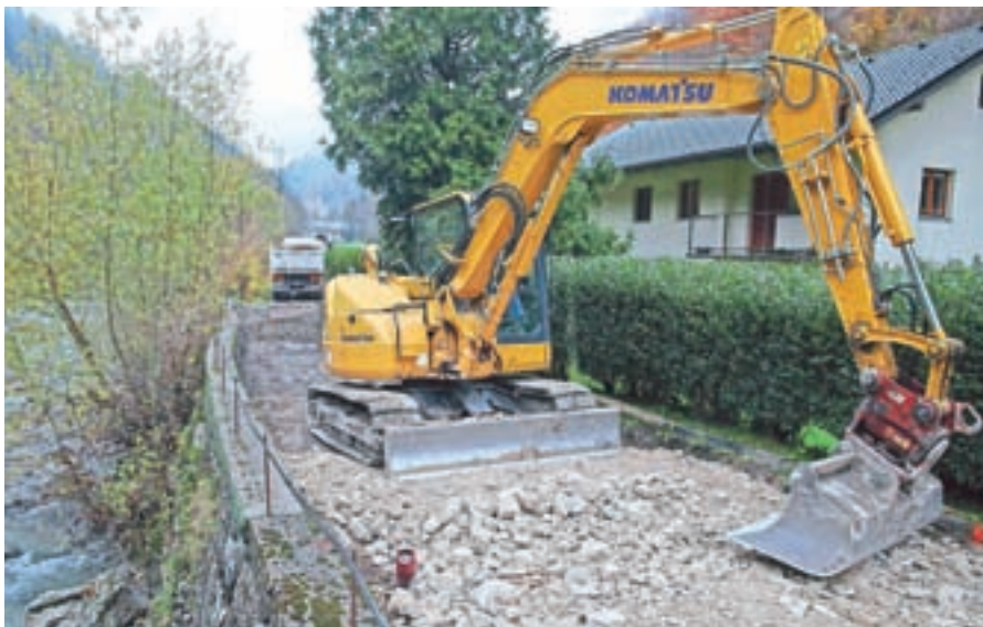
Gradnja nove kolesarske steze na Jesenovcu
