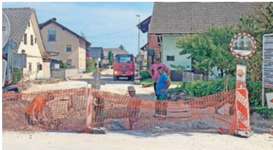
Gradnja komunalne infrastrukture poteka na Prebačevem in v Voklem.
