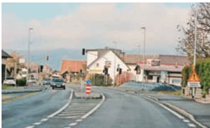
Od jeseni je obnovljena cesta skozi Godešič.
