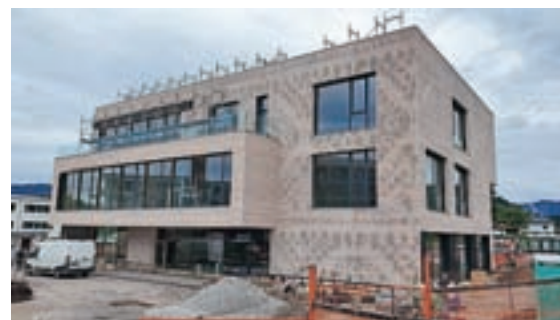
Na Selišah raste nov medgeneracijski center, ki bo po načrtih odprt že prihodnjo pomlad. / Foto: arhiv Občine Bled
