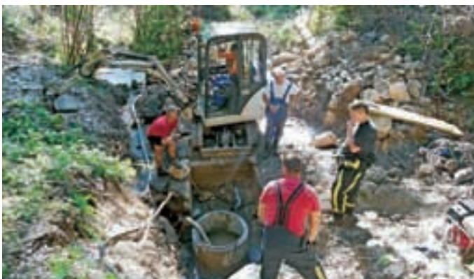
Vaščani Kokre so obnovili vodovodno zajetje.
