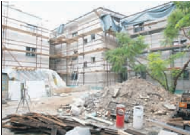
Trenutno stavbe prenavljajo, kar je le mogoče hitro, če bo gradbenikom služilo vreme, pa naj bi bila vsaj zunanja dela zaključena do konca novembra. / FOTO: GORAZD KAVČIČ
