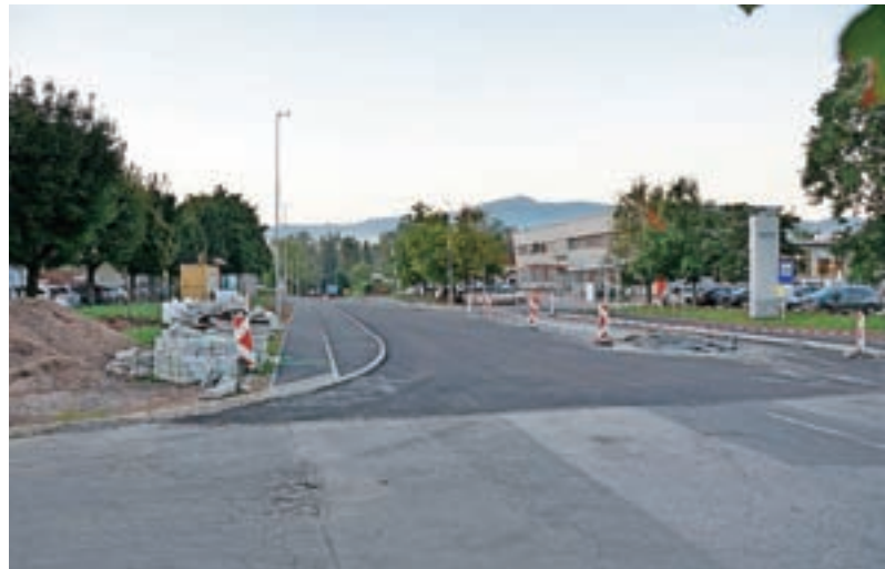
Rekonstrukcija Kidričeve ceste v dolžini 260 metrov je v zaključni fazi.
