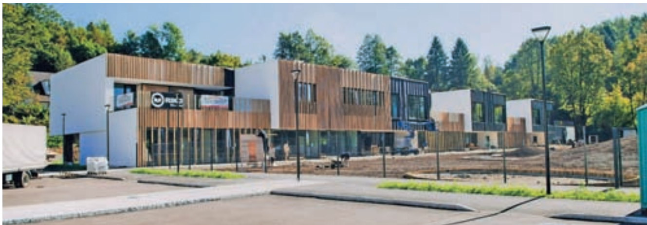
Končuje se gradnja vrtca Kamnitnik.
