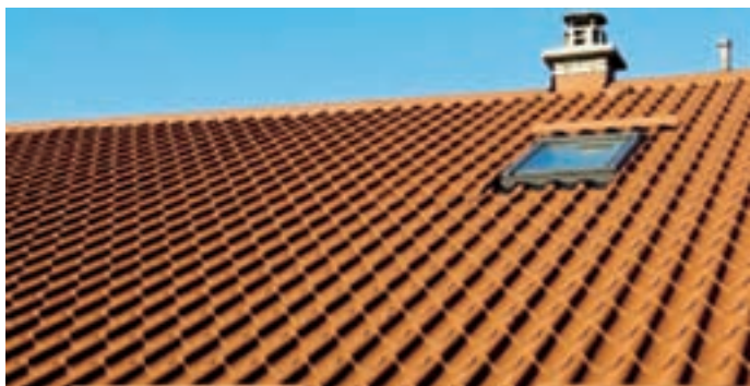
Od slemena do žleba v enem kosu. Hitra in enostavna montaža.
