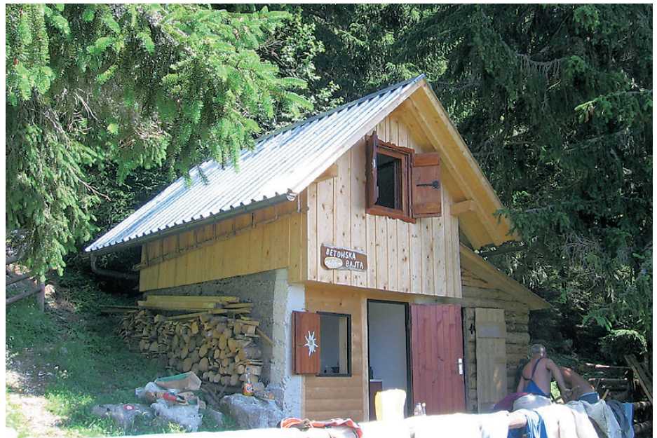
Zaključna dela pri nekdanji betonski bajti na Zabreški planini
