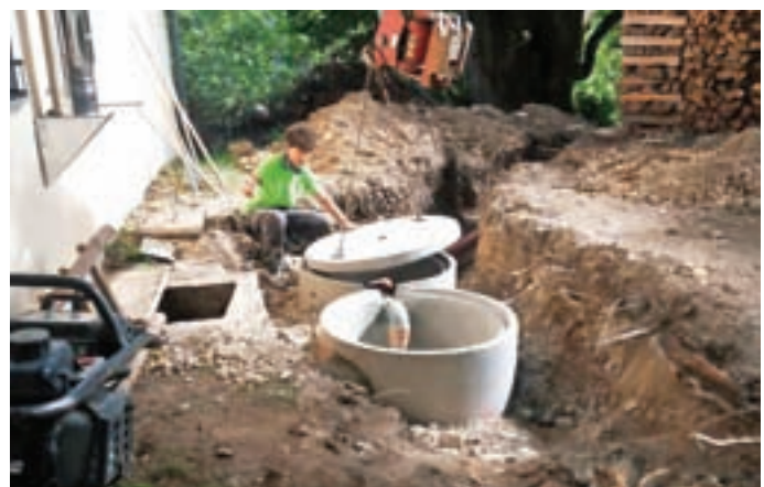
Urejanje dvorišča / Foto: arhiv župnišča
