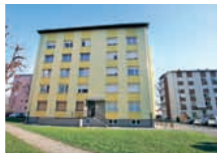
Tudi v letu 2015 se je nadaljevala energetska sanacija stavb v upravljanju družbe Domplan.
