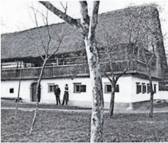
Bankova hiša, zgrajena leta 1740 (z gankom)
