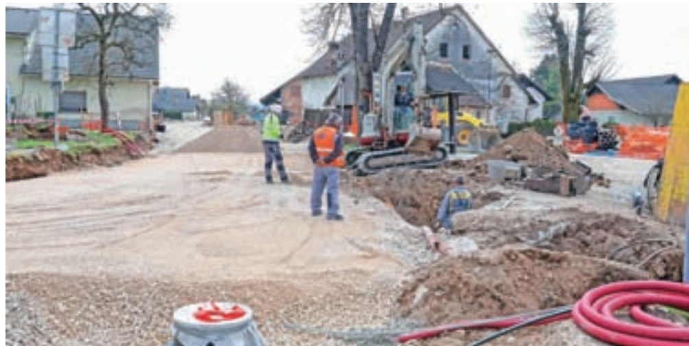
Gradnja kanalizacije na Prebačevem / FOTO: TINA DOKL
