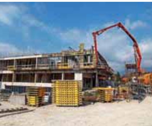
Gradnja Osnovne šole Frana Albrehta / FOTO: ALEŠ SENOŽETNIK
