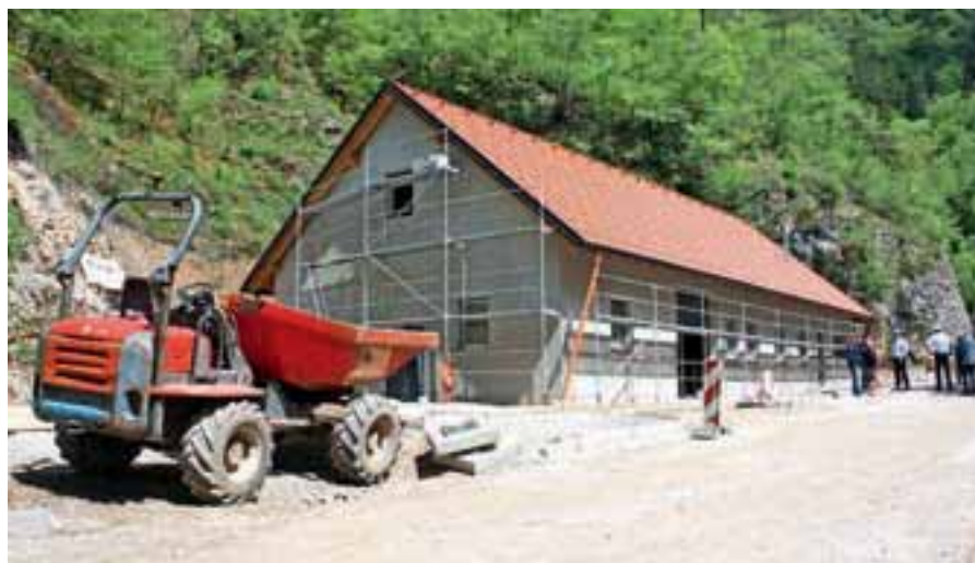
Ogled gradnje objekta za pripravo pitne vode v kanjonu Reke / FOTO: ARHIV OBČINE CERKLJE
