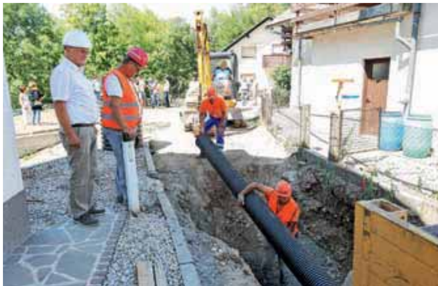
NA PREBAČEVEM so položili zadnjo cev javnega kanalizacijskega omrežja v občini Šenčur, dolgega 66 kilometrov.
