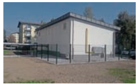
Prenovljena kotlovnica v Šorlijevem naselju
