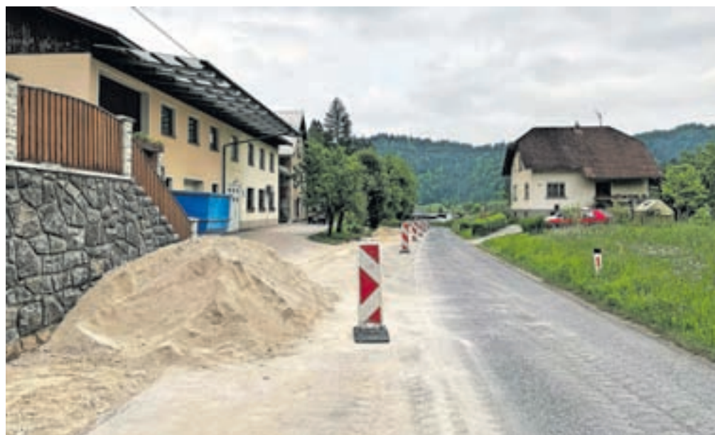
Ta čas poteka obnova Idrijske ceste, ob kateri bodo zgradili tudi pločnike. / FOTO: TANJA MLINAR
