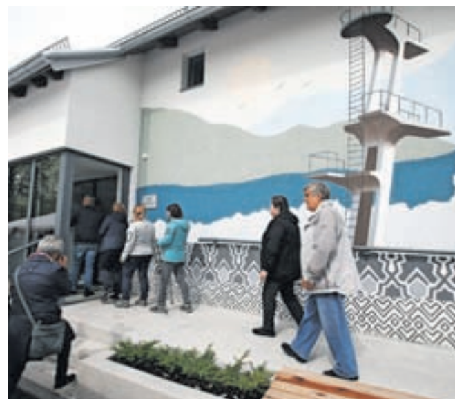
Osrednji motiv poslikave stavbe predstavlja silhueta nekdanjega skakalnega stolpa arhitekta Ivana Vurnika pred silhueto vrhov karavanskih gora. / FOTO: GORAZD KAVČIČ
