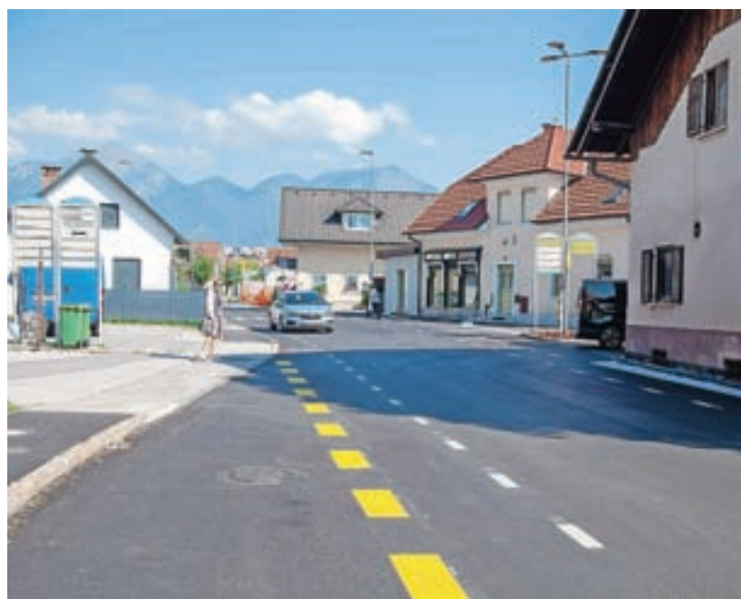
Gasilska cesta po zaključenih delih
