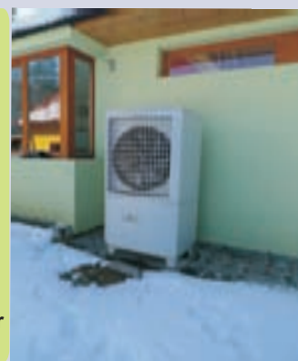
Toplotna črpalka zrak/voda, za samostojno ogrevanje stanovanjske hiše
