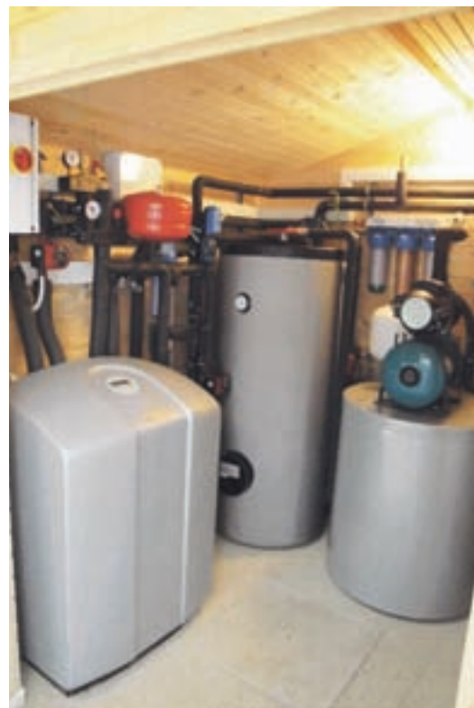
Visoko učinkovita toplotna črpalka zrak-voda za ogrevanje stanovanjske hiše z radiatorskim sistemom (Vir: Termo-tehnika, d. o. o.)
