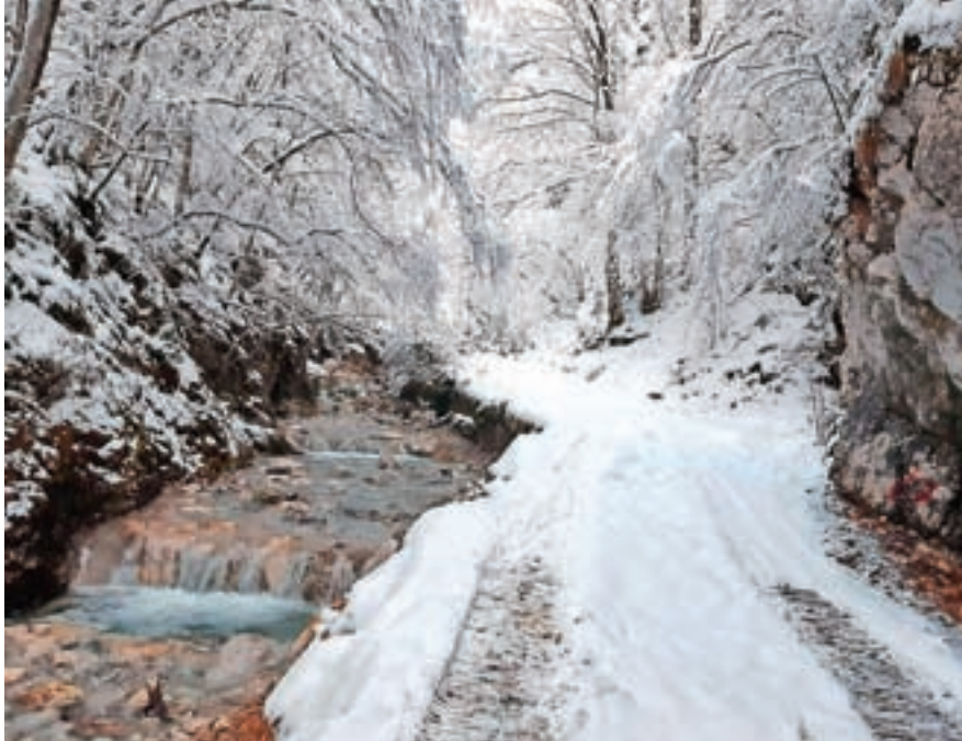
V strugi Bistrice od vodovodnega zajetja Nova vas navzdol so na novo urejeni umirjevalni pragovi. / Foto: arhiv zadruge
