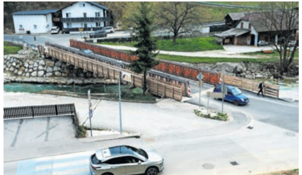
Montažni most čez Kamniško Bistrico v Zgornjih Stranjah bo nadomestil sodobni dvopasovni most. / FOTO: MAŠA LIKOSAR
