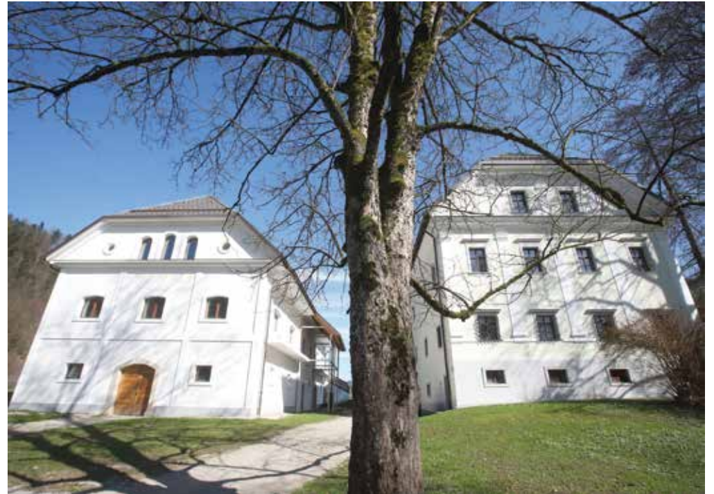
Tako Dvorec Visoko kot sosednje gospodarsko poslopje sta v zadnjih desetih letih dobila novo podobo. / Foto: Gorazd Kavčič
