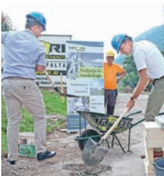
V Poslovni coni na Jesenicah so začeli graditi infrastrukturo.
