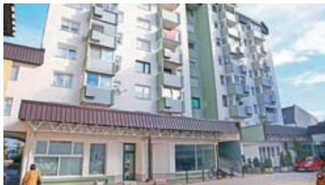
Obnovljen stanovanjski blok na Trgu Prešernove brigade 10 v Kranju, ki ga je leta 2018 zajel velik požar
