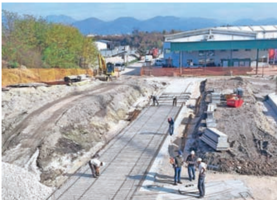
Gradnja zbirnega centra za komunalne odpadke
