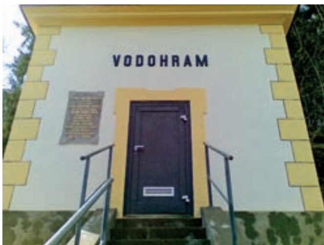
Grajski vodohran, obnovljen leta 2010, zgrajen pa 1902 s strani odgovornih loških meščanov, ki so danes navedeni na plošči ob vhodu v objekt
