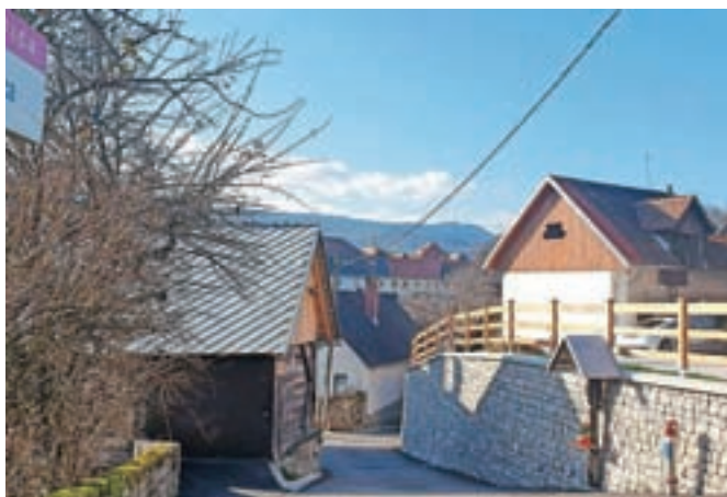
V Gubčevi ulici so obnovili cesto, zgradili nov oporni zid in uredili komunalno infrastrukturo.
