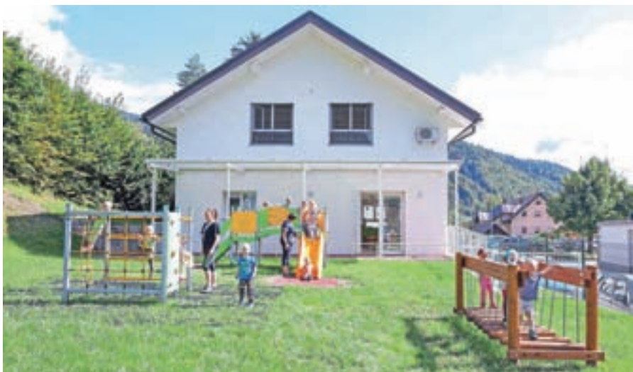
V obnovljenem dodatnem objektu Vrtca Železniki sta dve skupini otrok.
