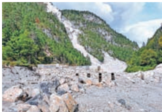
Gradnja zaplavne pregrade na vodotoku Belca
