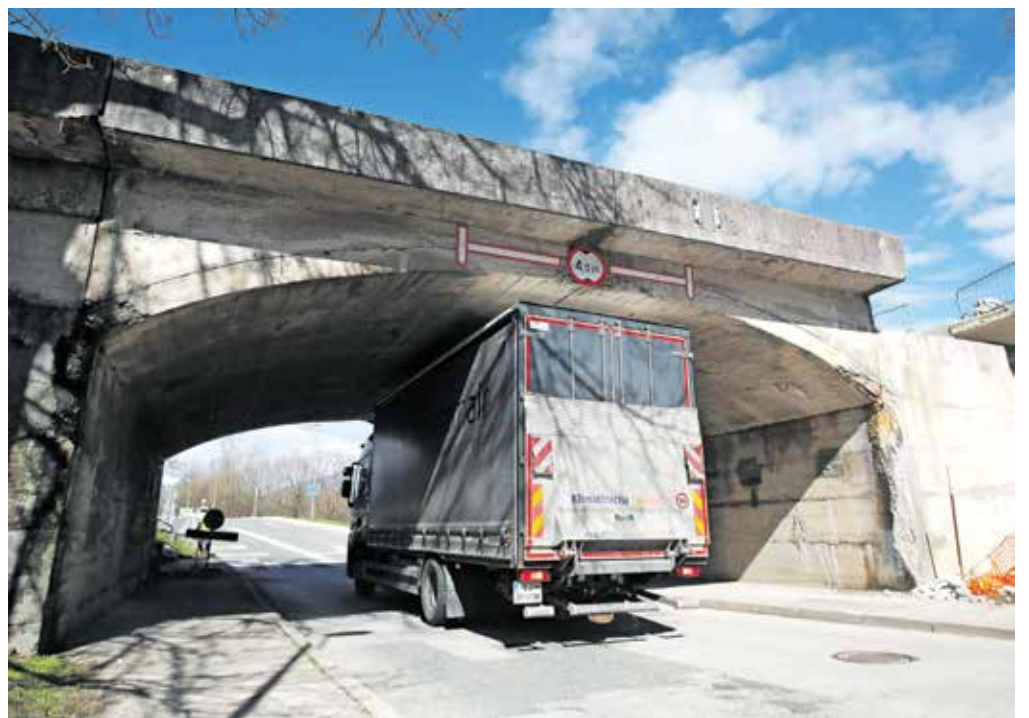
Z obnovo podvoza v Savski loki bodo omogočili dvosmerni promet tudi za večja tovorna vozila. / Foto: Gorazd Kavčič
