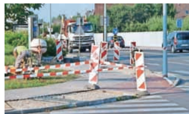
Prenova odsekov Ljubljanske ceste je že končana.
