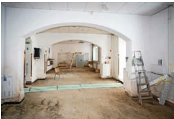
Takole je trenutno videti pritličje občinske stavbe. Krajevni urad Medvode bo še nekaj časa zaprt. / Foto: Peter Košenina
